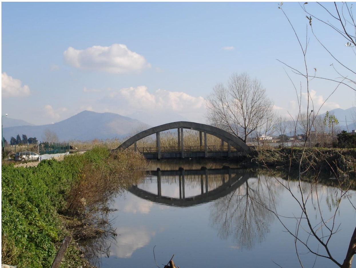
Figura 5: Ponte di attraversamento del Fiume Sarno nel territorio di San Marzano sul Sarno
